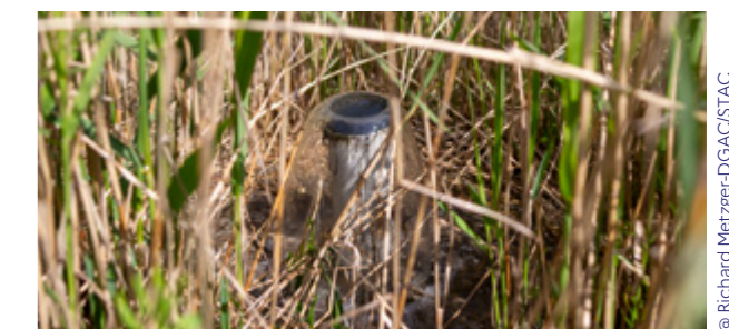
Système d'arrivée d'eau de marais filtrant
