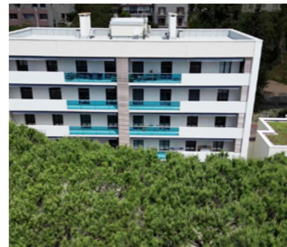
Rénovation énergétique du bâtiment U-Ricantu de la GTA à Ajaccio.
