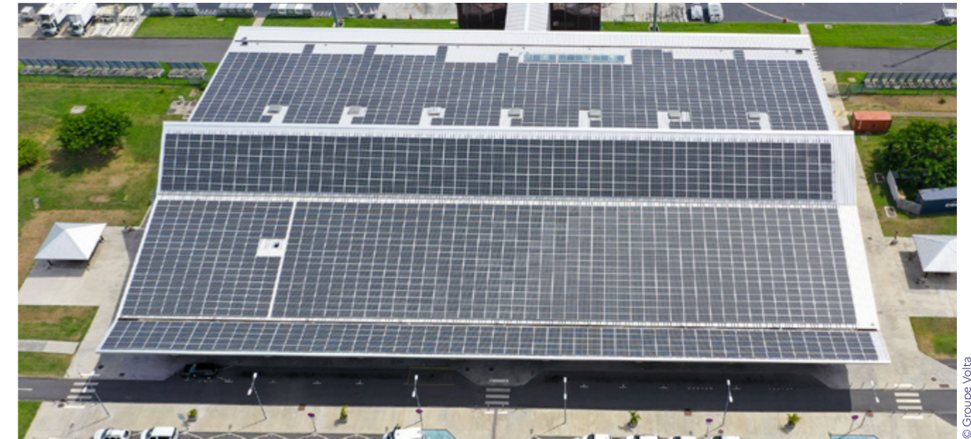
Toiture photovoltaïque de l'aéroport de Mayotte.
