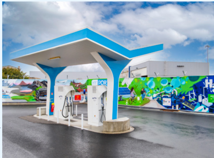
Station hydrogène pour alimentation des bus et chariots à bagages.
