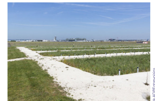
Vue générale sur les marais filtrants de l'aéroport d'Orly
