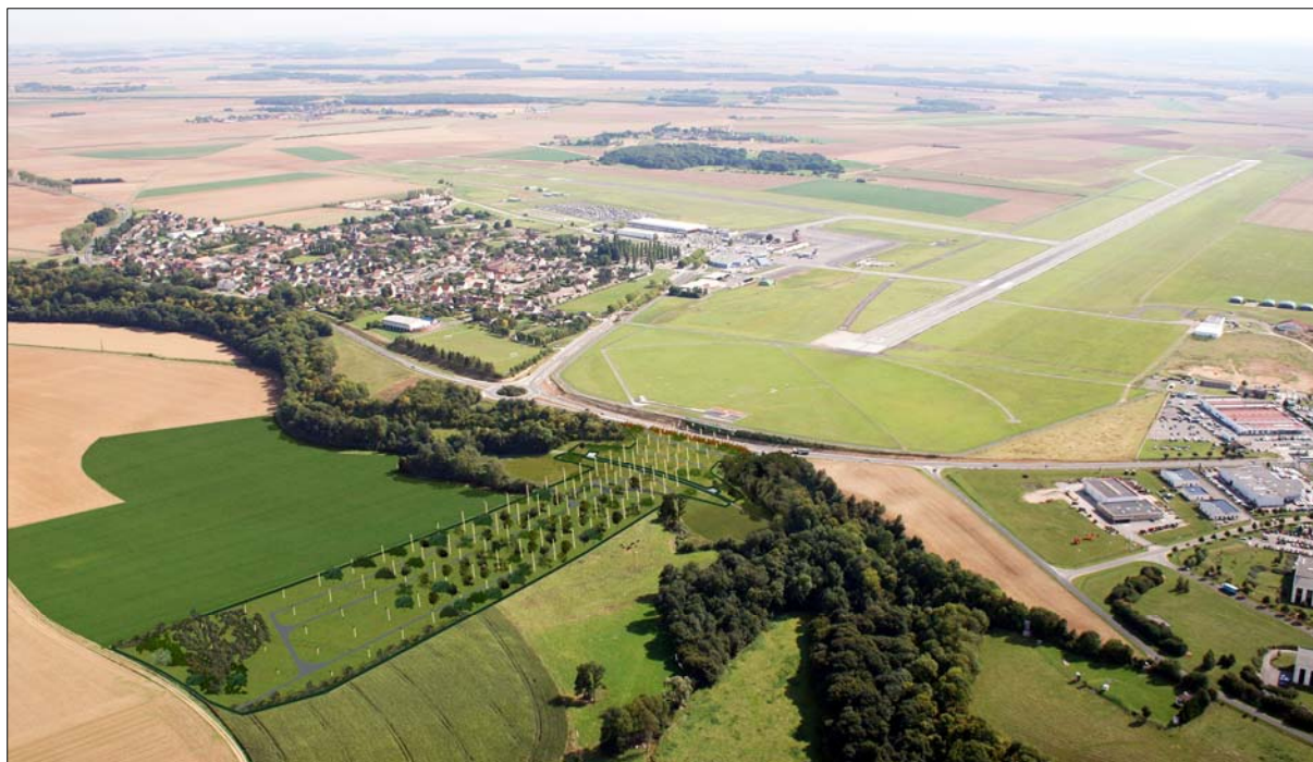
Photo 29 : Vue du sud-ouest du projet
